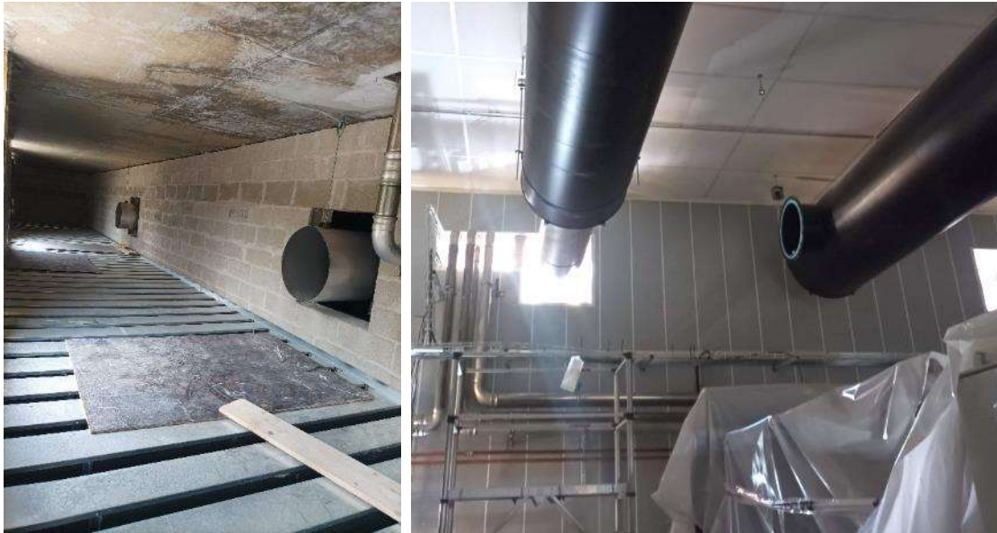
Figure 9 : traitement acoustique maximum pour les locaux GE
