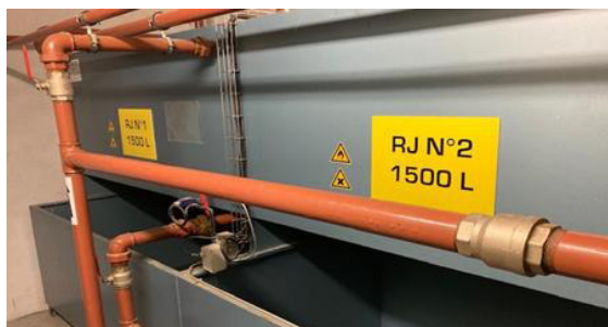
Illustration 15 : Nourrices fioul présentes dans un local spécifique du bâtiment U
