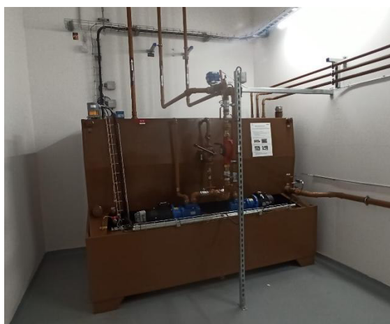
Illustration 16 : Photographie d'un réservoir journalier installé sur P1
