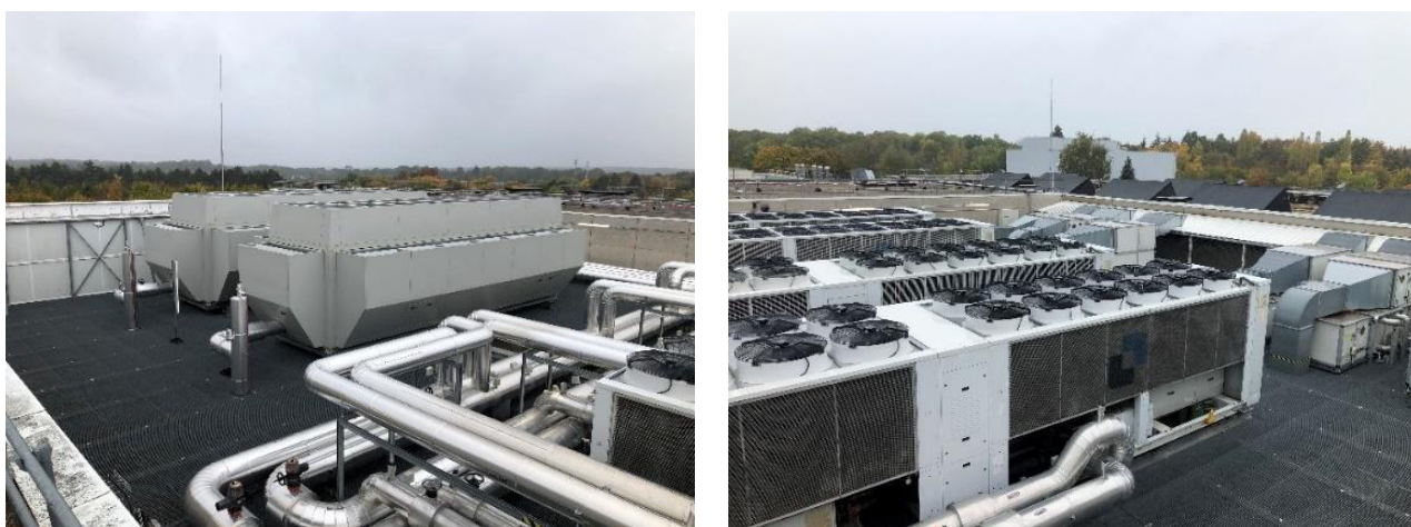
Illustration 20: Photographie des groupes froids en toiture du bâtiment T
