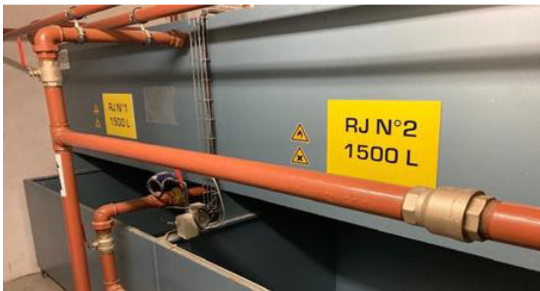
Illustration 16 : Nourrices fioul présentes dans un local spécifique du bâtiment U
