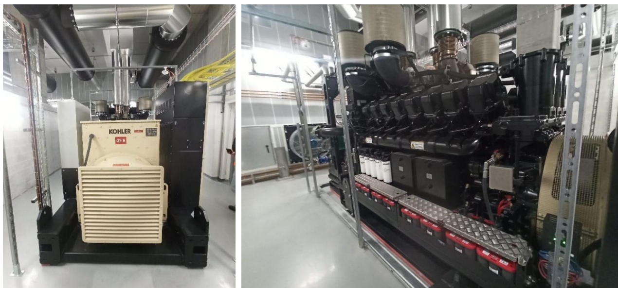
Illustration 26 : Photographie d'un groupe électrogène installé sur P1
