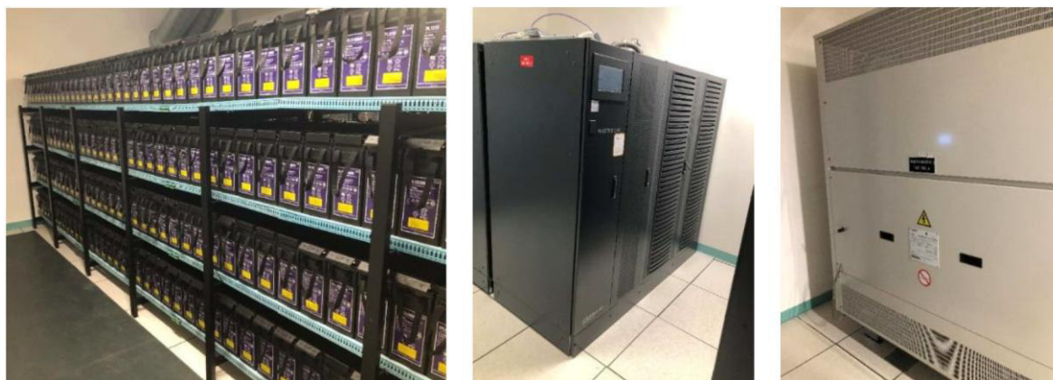
Illustration 14 : Photographie d'une salle batterie, d'un onduleur et d'un transformateur
