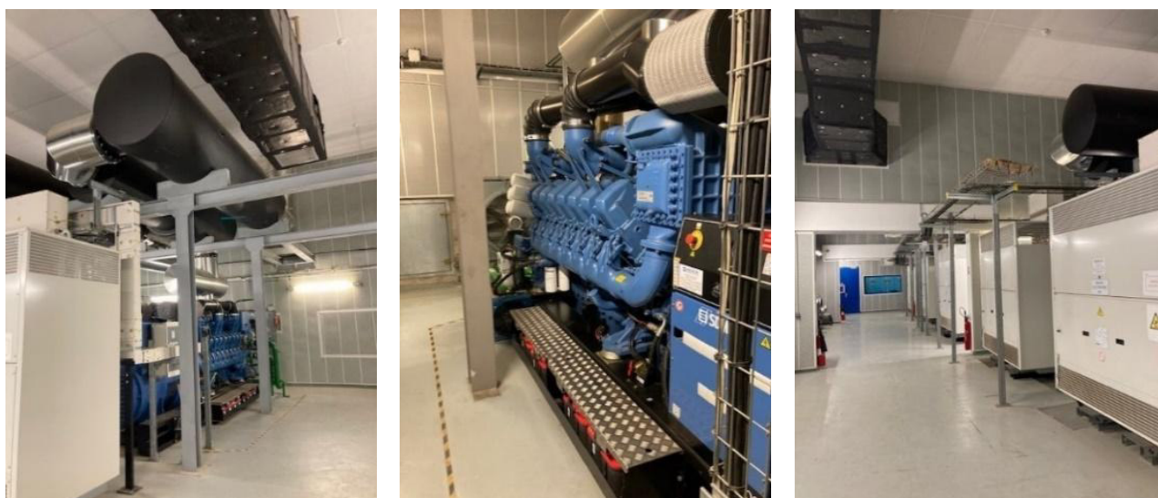
Illustration 15 : Groupes électrogènes présents dans le bâtiment U
