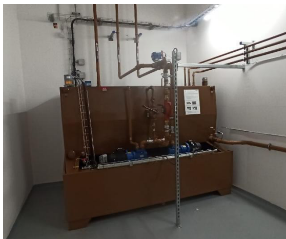
Illustration 27 : Photographie d'un réservoir journalier installé sur P1
