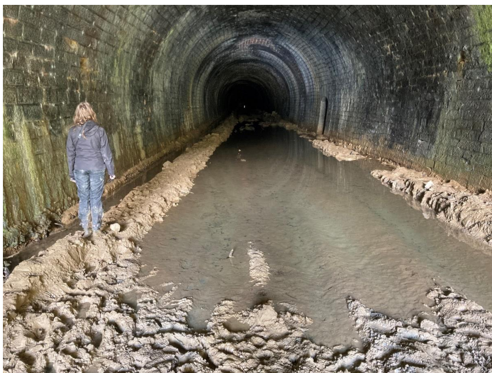
Figure 23 : mare abreuvoir dans l'entrée sud du tunnel en octobre 2024
