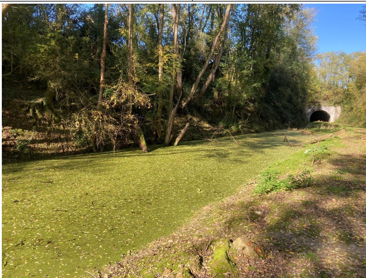
Figure 25 : Echelles d'écoulement des eaux alimentant la grande mare sud
