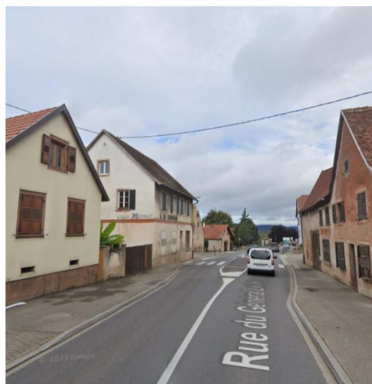
Figure 2 : Vue de la traversée de Singrist au droit de la RD 1004
