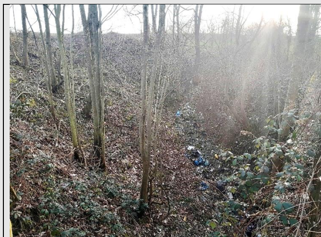
Vue de talus créé par le remblai dans l'emprise de l'ancienne voie ferrée
