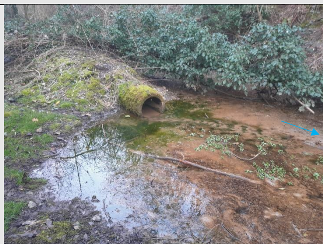
Vue du drain en sortie de zone remblayée
