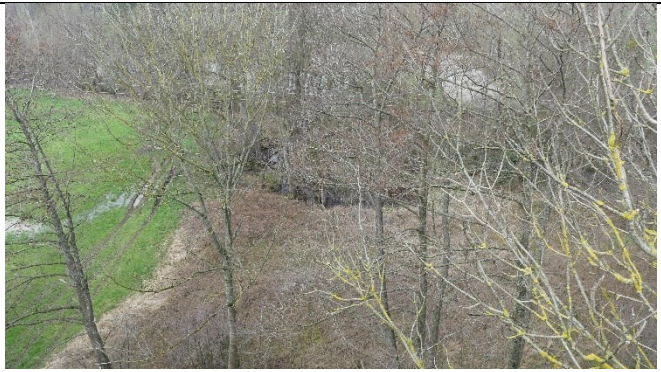
Vue depuis le haut du viaduc le 14/03/2024
