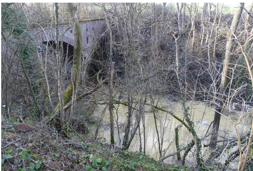
Vue sur le tronçon nord, complètement inondé lors du passage le 08/02/2022
