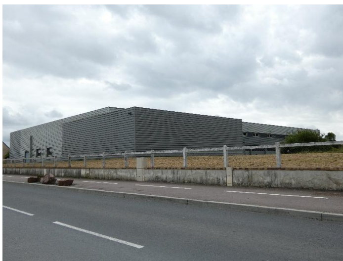
Bâtiment inutilisé à Douvres-la-Délivrande, au croisement de la RD7 et de la rue Jean Perrin (source : Géostudio)
