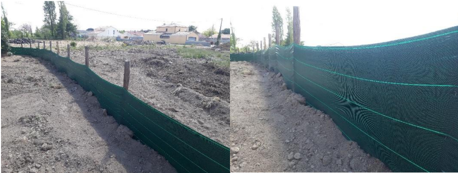
Exemple de géotextile prévu sur le chantier pour empêcher le passage des amphibiens
