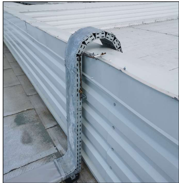
Exemple de capotage lors de croisement câbles électriques / conducteur de descente paratonnerre
