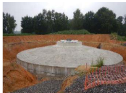
Fondation en béton armé
