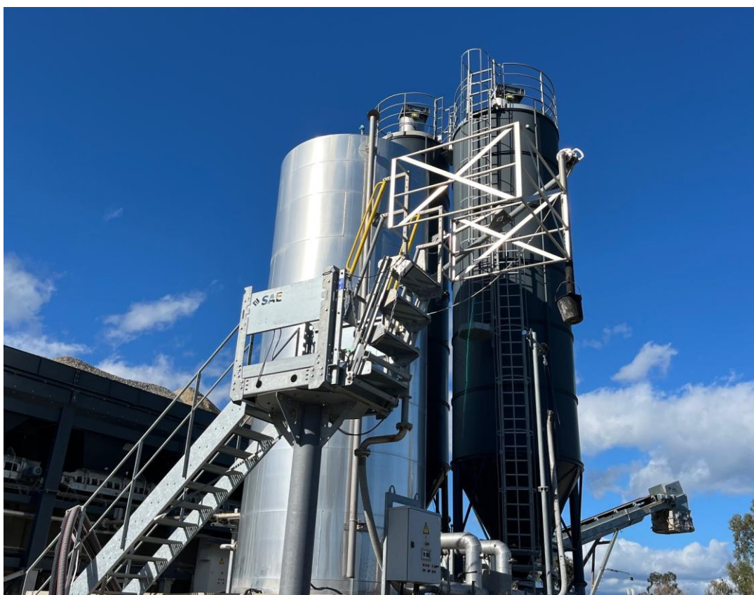
Silos de stockage
