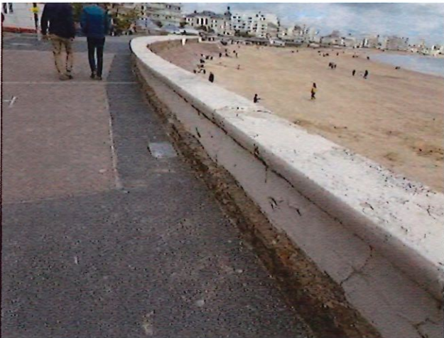
Altération et fissures diverses au droit du muret en béton (à gauche) / Tête du muret en béton altérée (à droite)
