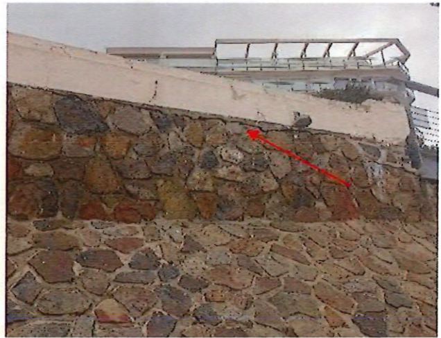
Altération et fissures diverses au droit du muret en béton (à gauche) / Tête du muret en béton altérée (à droite)
