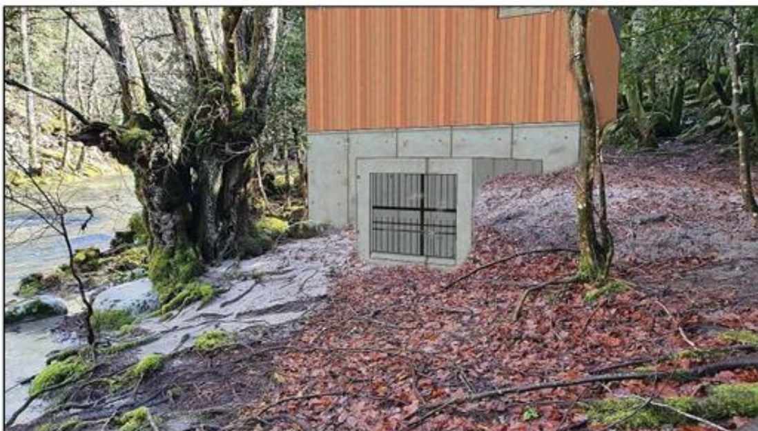
En vue aval (façade à l'OSO).
