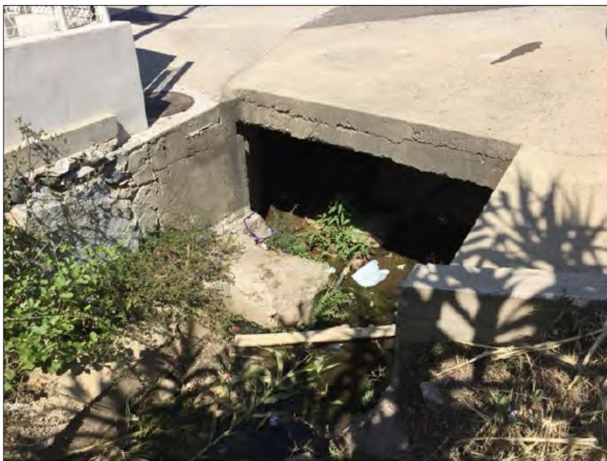
Figure 11 : Photo de l'ouvrage hydraulique passant sous la RT 11 au droit de la parcelle OB 621
