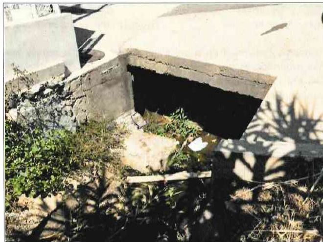
Figure 11 : Photo de l'ouvrage hydraulique passant sous la RT 11 au droit de la parcelle OB 621
