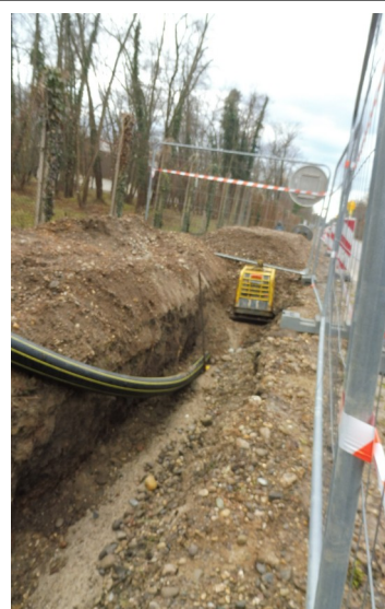
Travaux de pose de canalisations le long de la RD39 (photo P. Spies – 06/01/25)
