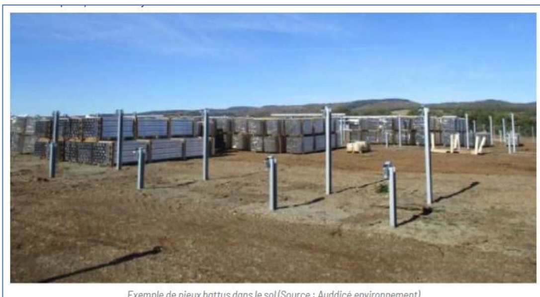
Exemple de pieux battus dans le sol (Source : Auddicé environnement)
