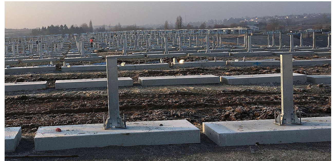
Exemple de longrines en béton (Source : Maison Bleue)
