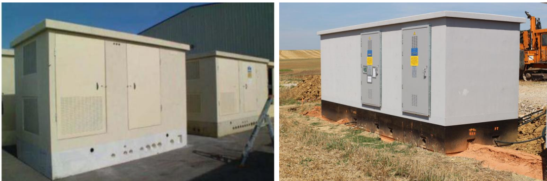
Exemple de poste de transformation et de poste de livraison (Sources : IRISOLARIS et Ora environnement)
