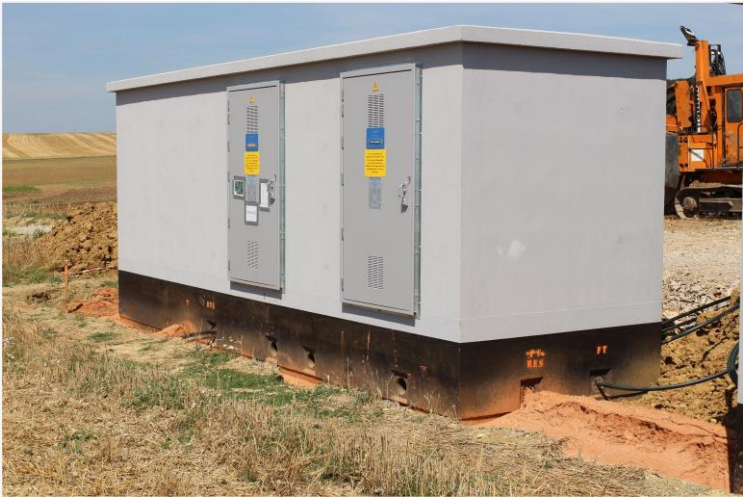
Installation d'un poste livraison (Source : Ora environnement)
