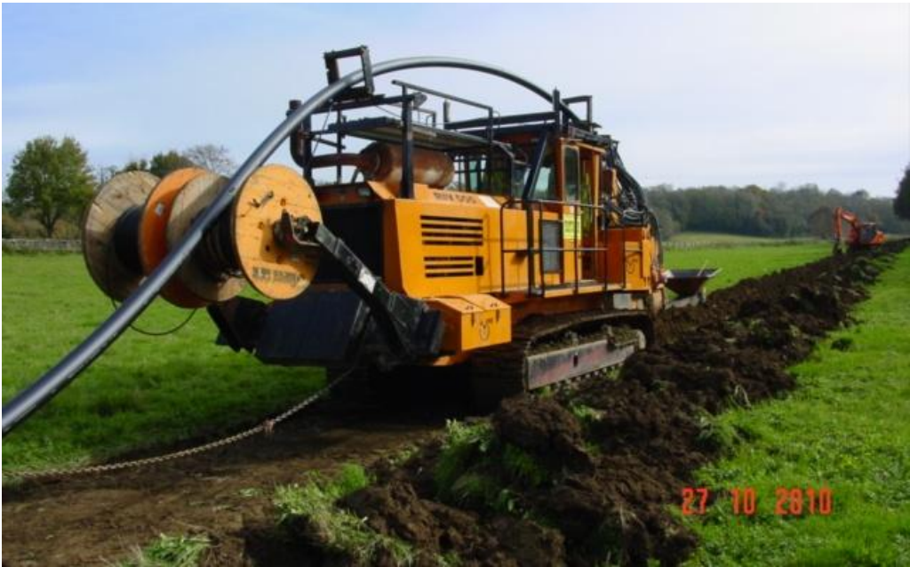
Photo 40 : Type de trancheuse utilisée dans le cadre d'enfouissement de câbles (Source : tattu.fr)
