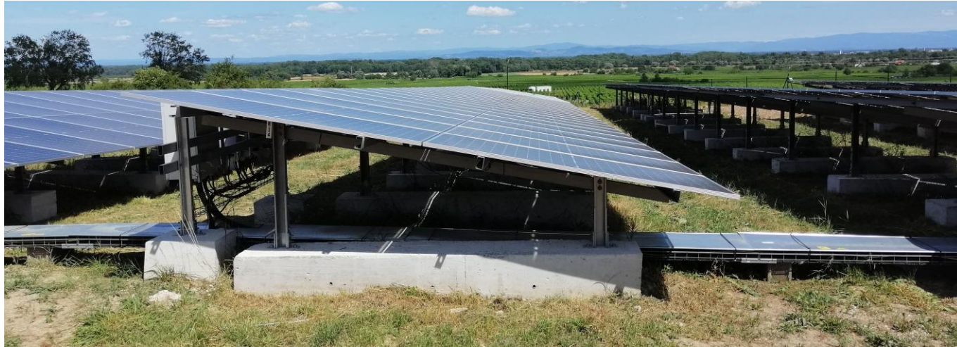
Exemple de support fixe (Source : Ora environnement)
