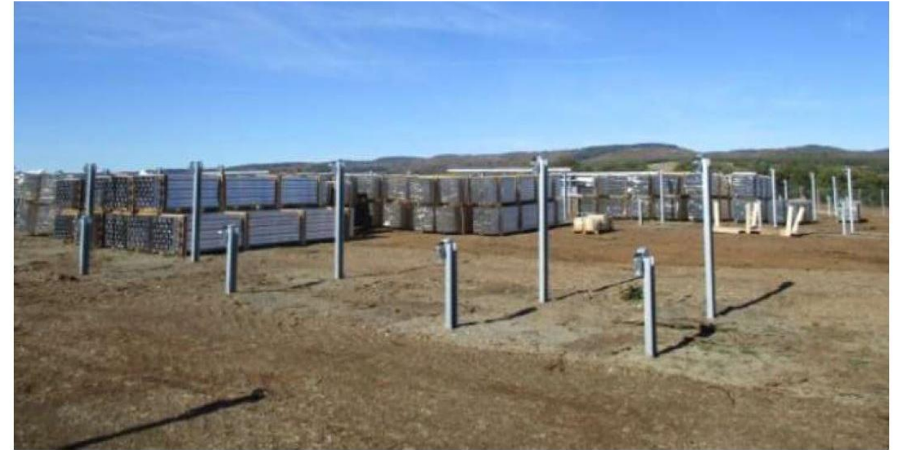
Exemple de pieux battus dans le sol (Source : Auddicé environnement)
