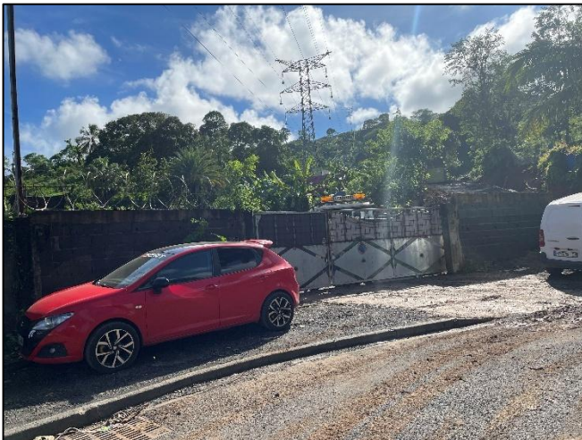
Figure 26 : Photo entrée Sud du site survolée par ligne aérienne
