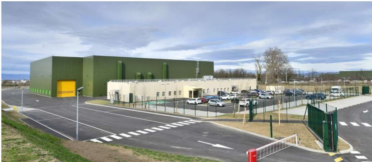
Usine de production et siège social de la société FMI Process à L'Horme (42)
