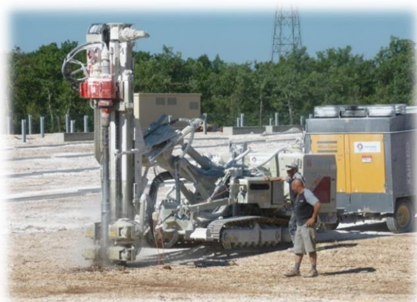
Illustration 8 - Ancrage au sol par pieux battus
