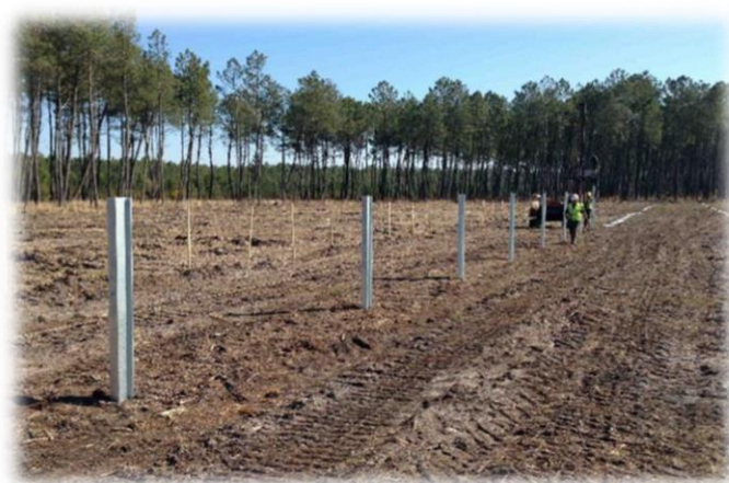
Illustration 8 - Ancrage au sol par pieux battus
