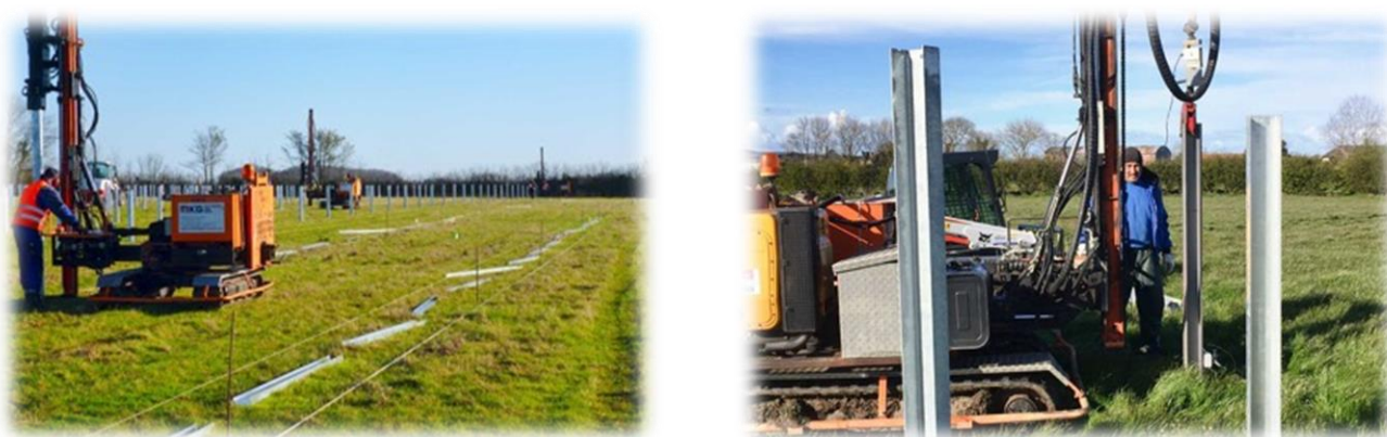
Exemple de batteuse de pieux (source mkg-goebel.de)
