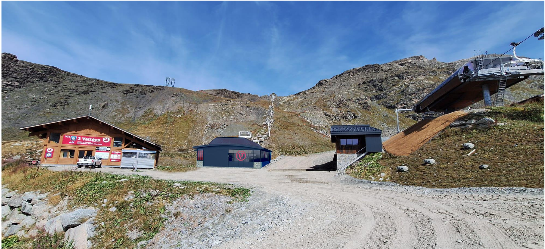
Figure 5 : Vue été de la gare aval et de la ligne
