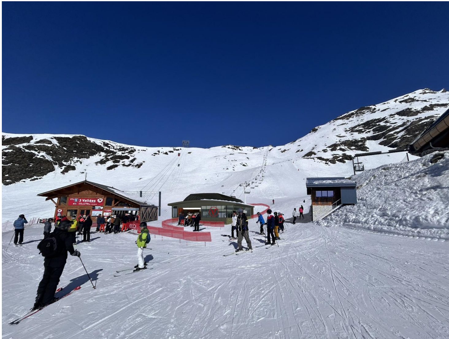
Figure 4 : Vue hiver de la gare aval et de la ligne
