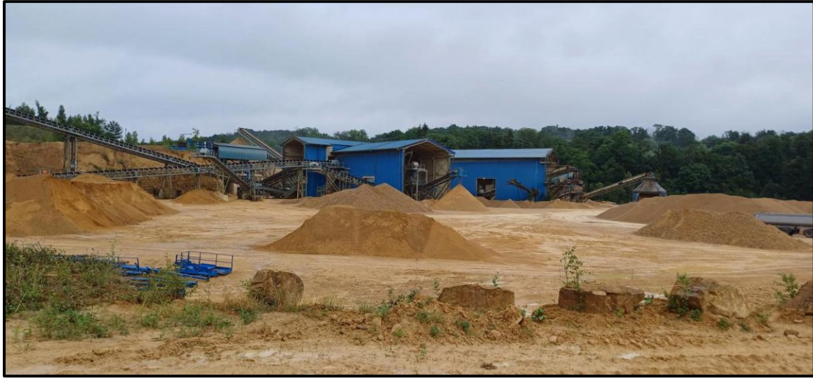
Figure 7 : Installation de traitement sur le site
