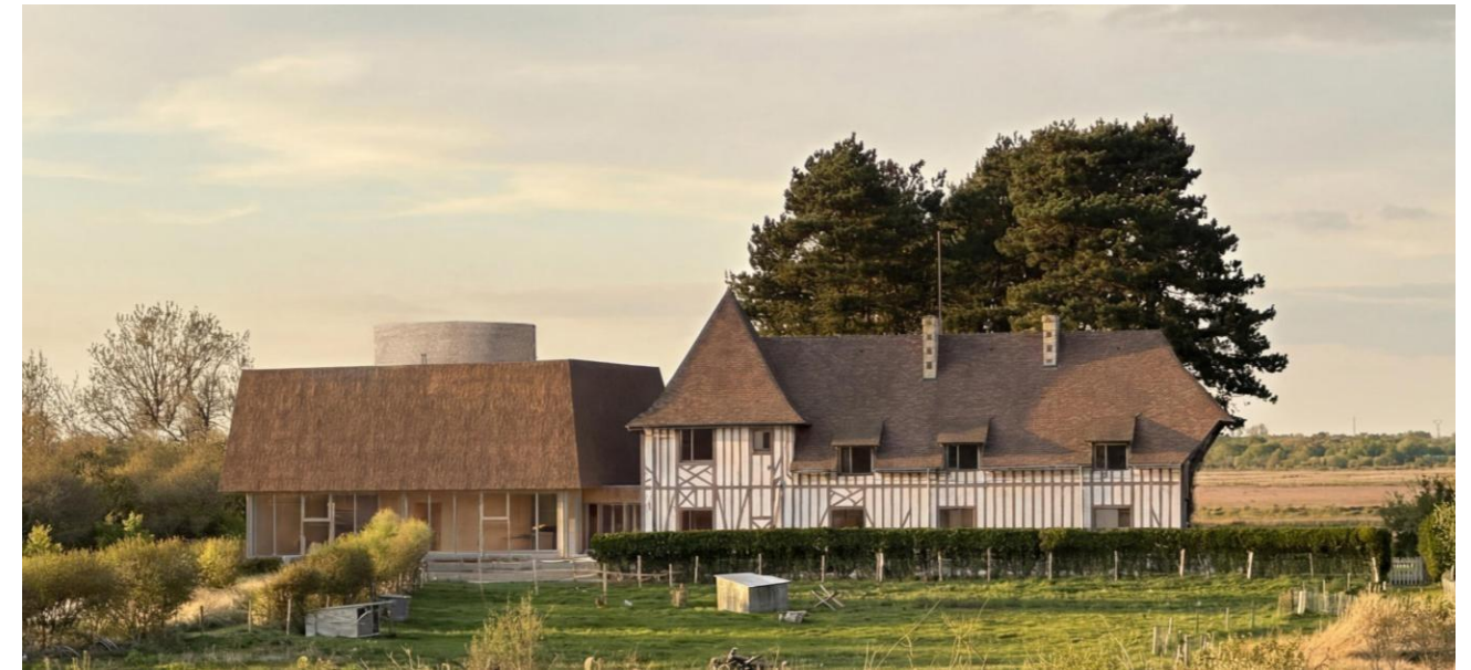
Figure 3: Extension de la Maison de la Nature (façade sud)
