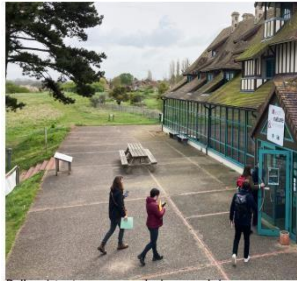
Dalle existante avec son calepinage en briques
