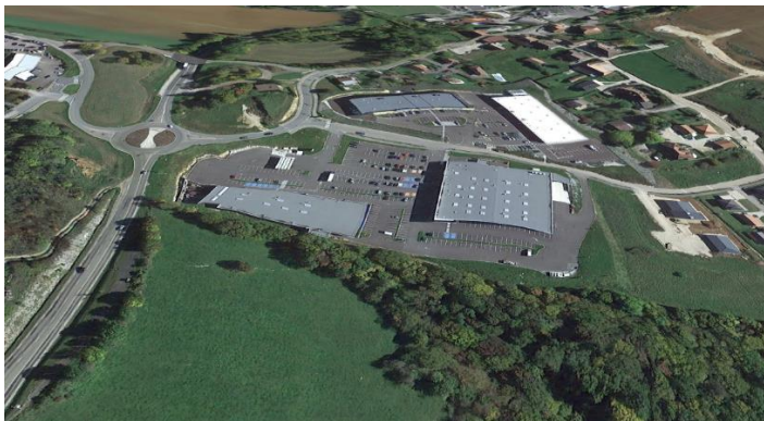
Entrée de ville de Baume-les-Dames par la RD683 –ZAC de Champvans (Google Earth)
