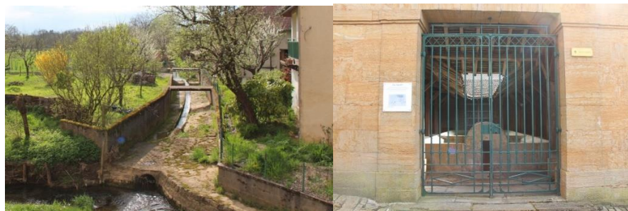
Ouvrage hydraulique et lavoir à Rougemont
