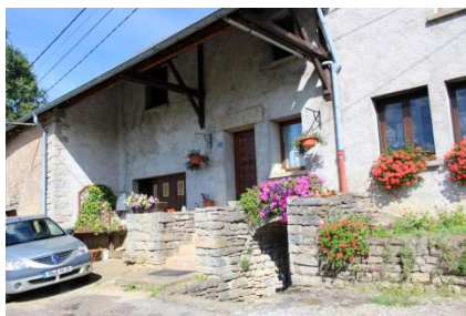
Exemple de maison vigneronne : rehaussement du RDC et porte d'accès de cave en pierre
