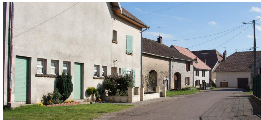
Des espaces enherbés simples qui sont parfois la meilleure manière de mettre en valeur les bâtiments dans un contexte rural. Les clôtures perturbent l'harmonie des fronts de rue construits par les façades des bâtiments
