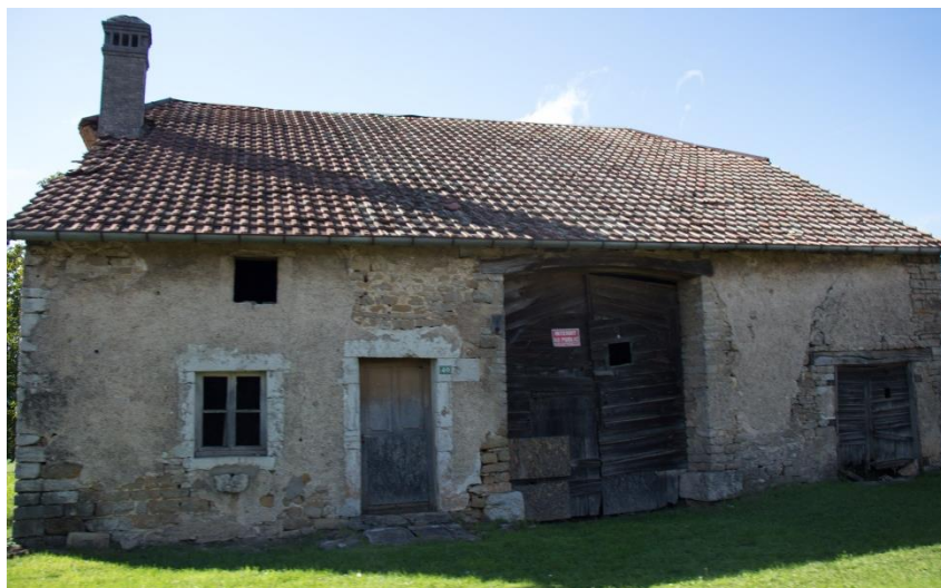
Exemple de bâtiment agricole resté "dans son jus" avec ses 3 travées
