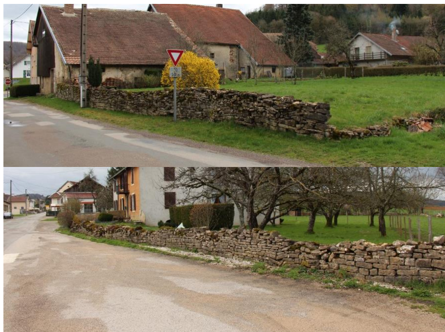
Murs en pierre sèche à Sancey
