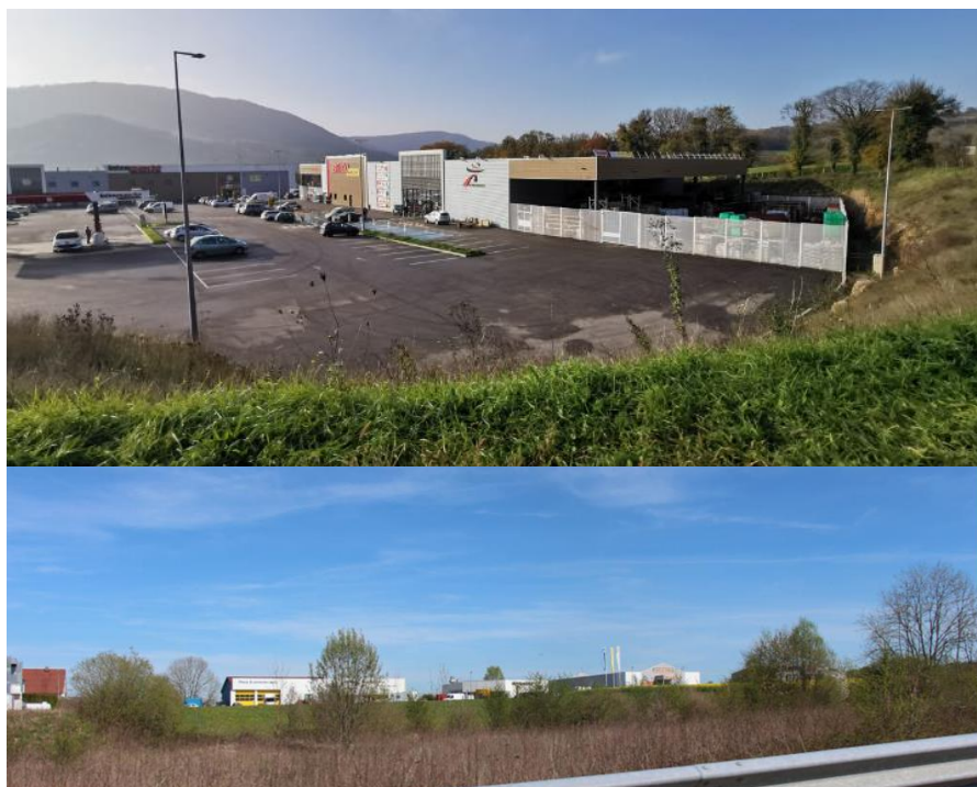
L'impact du développement d'activités en entrées de ville : l'exemple de Baume-les-Dames (haut) et de l'Isle-sur-le-Doubs (bas)
