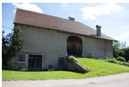
Exemple d'adaptation à la pente par la création d'une rampe d'accès et création d'une cave
