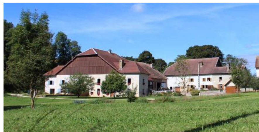
Exemple de maison bloc aux volumes imposants
