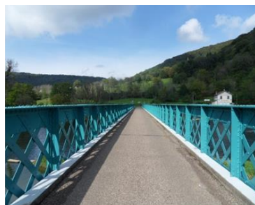
Pont sur le Doubs à Hyèvre-Paroisse
