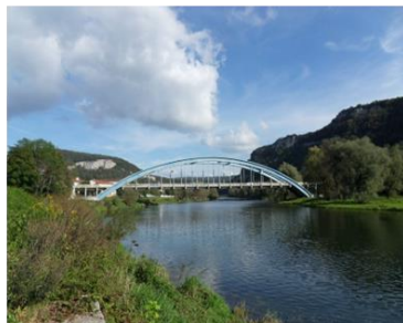
Pont sur le Doubs à Baume-les-Dames
