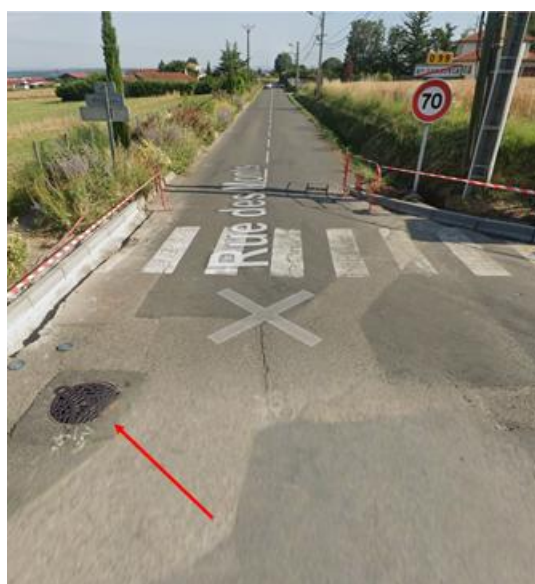
Figure 24 : Localisation du regard des eaux usées Rue des Monts
