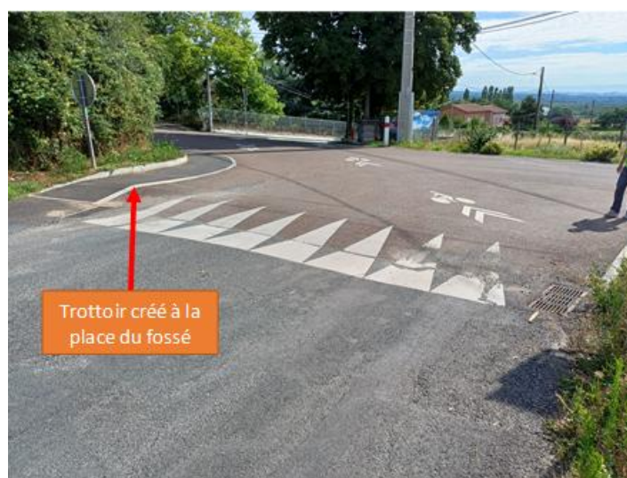
Figure 26 : remplacement d'un fossé par une canalisation
