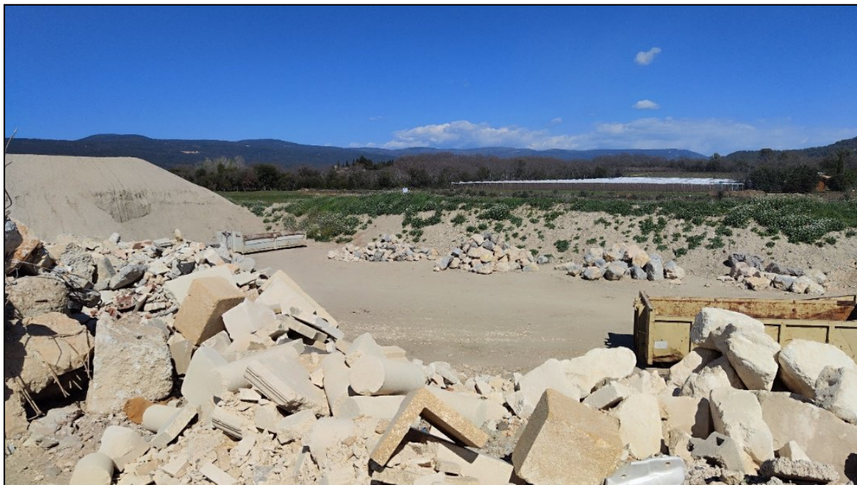
Photo : Matériaux admis sur le site de la plateforme
