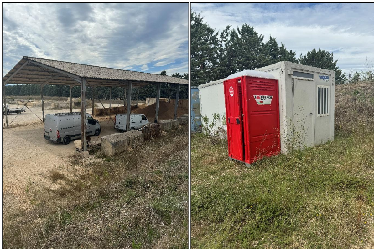
Photo 3 : Installations annexes présentes sur le site
