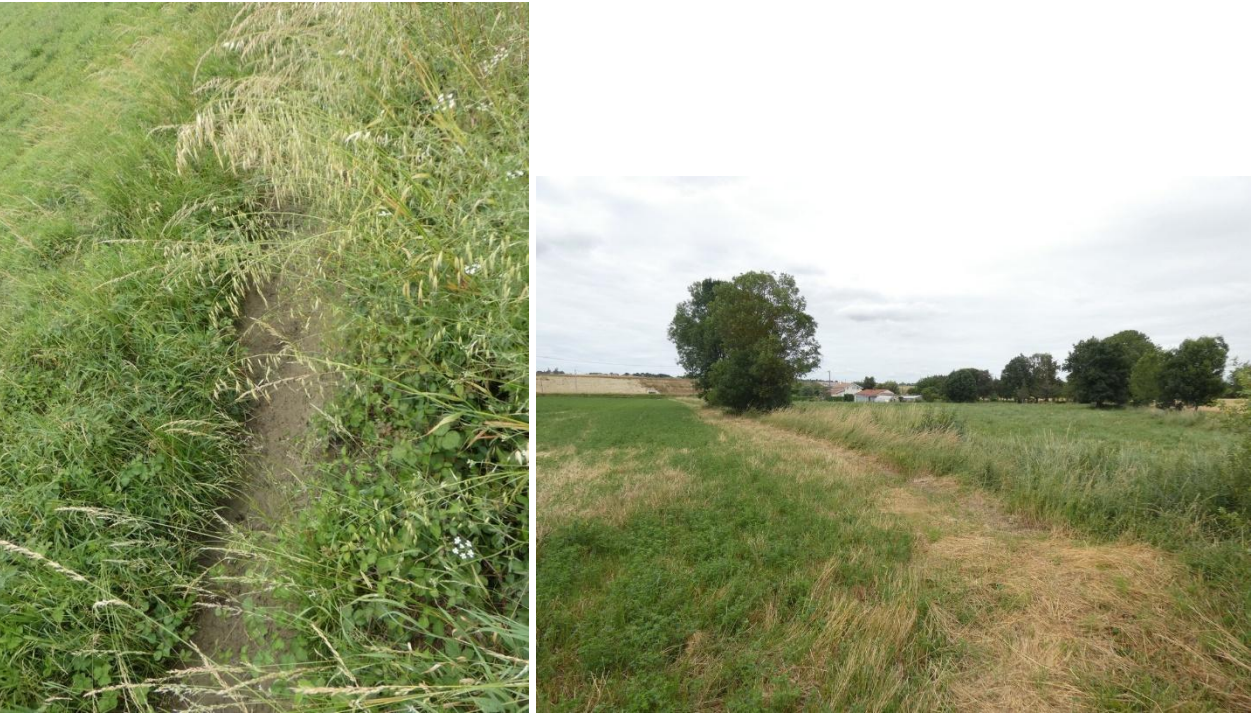
Fossé 11002 à entretenir avec atterrissements ponctuels
