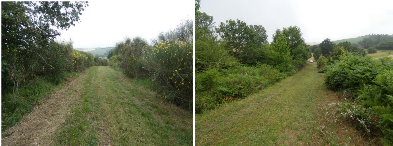
Débroussaillage réalisé et élagage projeté
