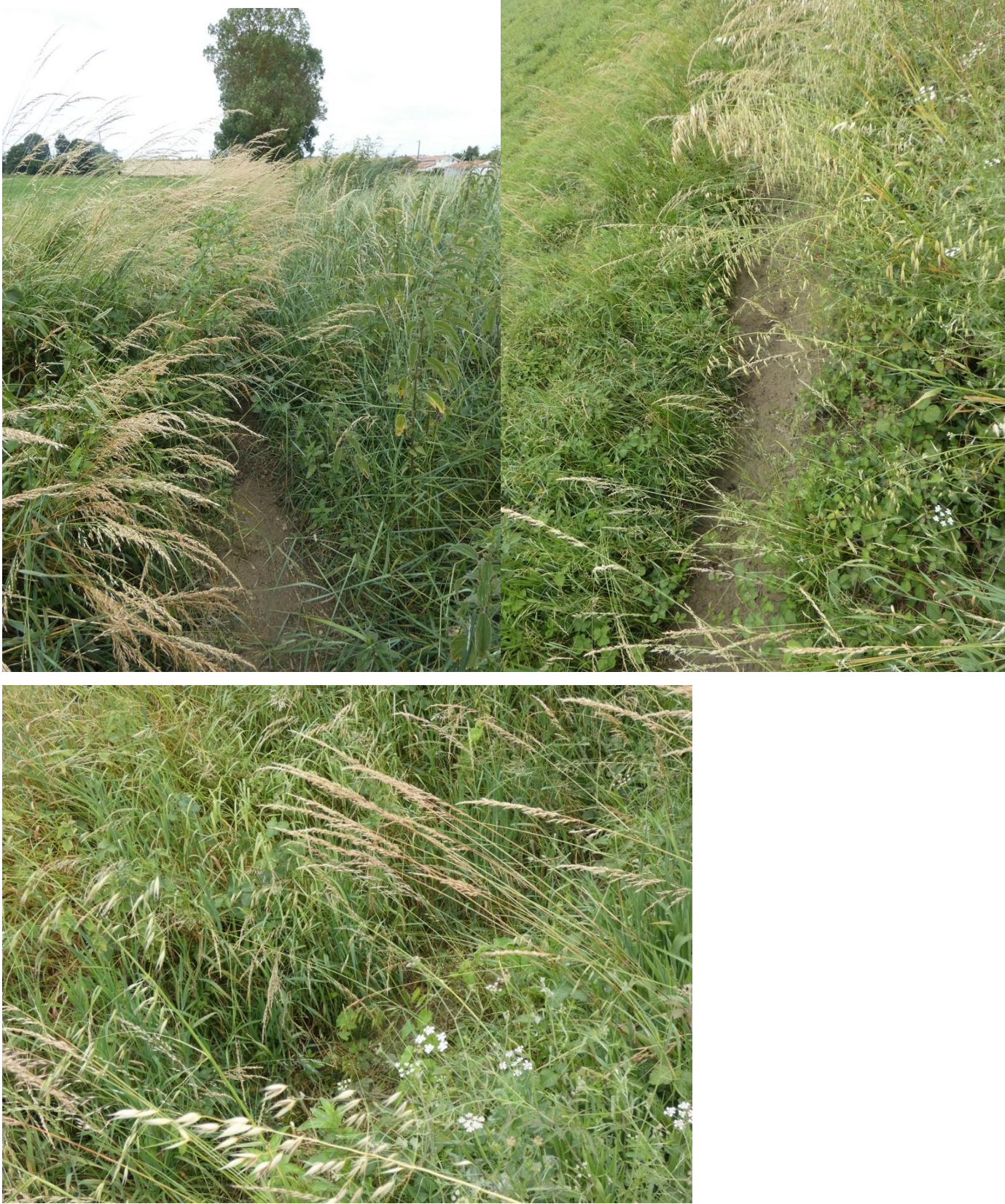
Figure 47 : Photographies du fossé visé par les travaux 11002 (source : ADRET Nature, 2026)
