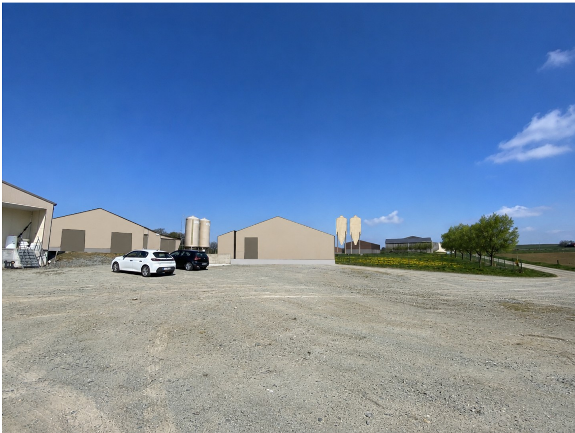
Vue après travaux
