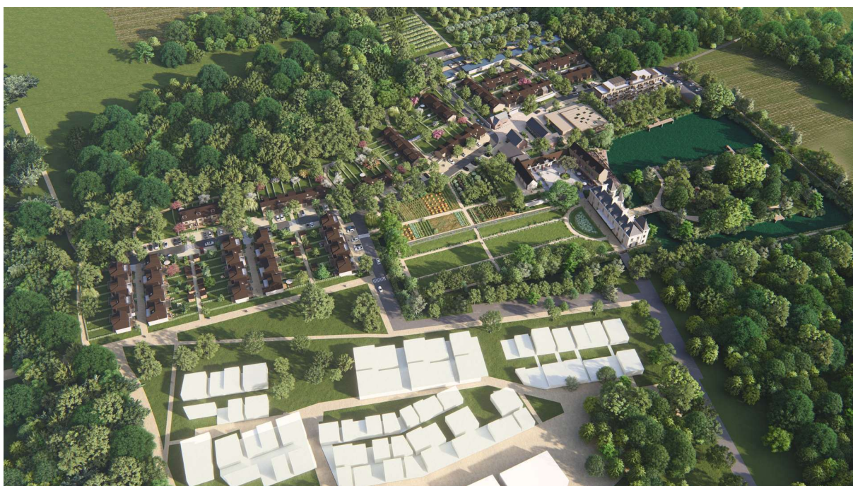
Figure 13 : Vue aérienne depuis la ZAC
