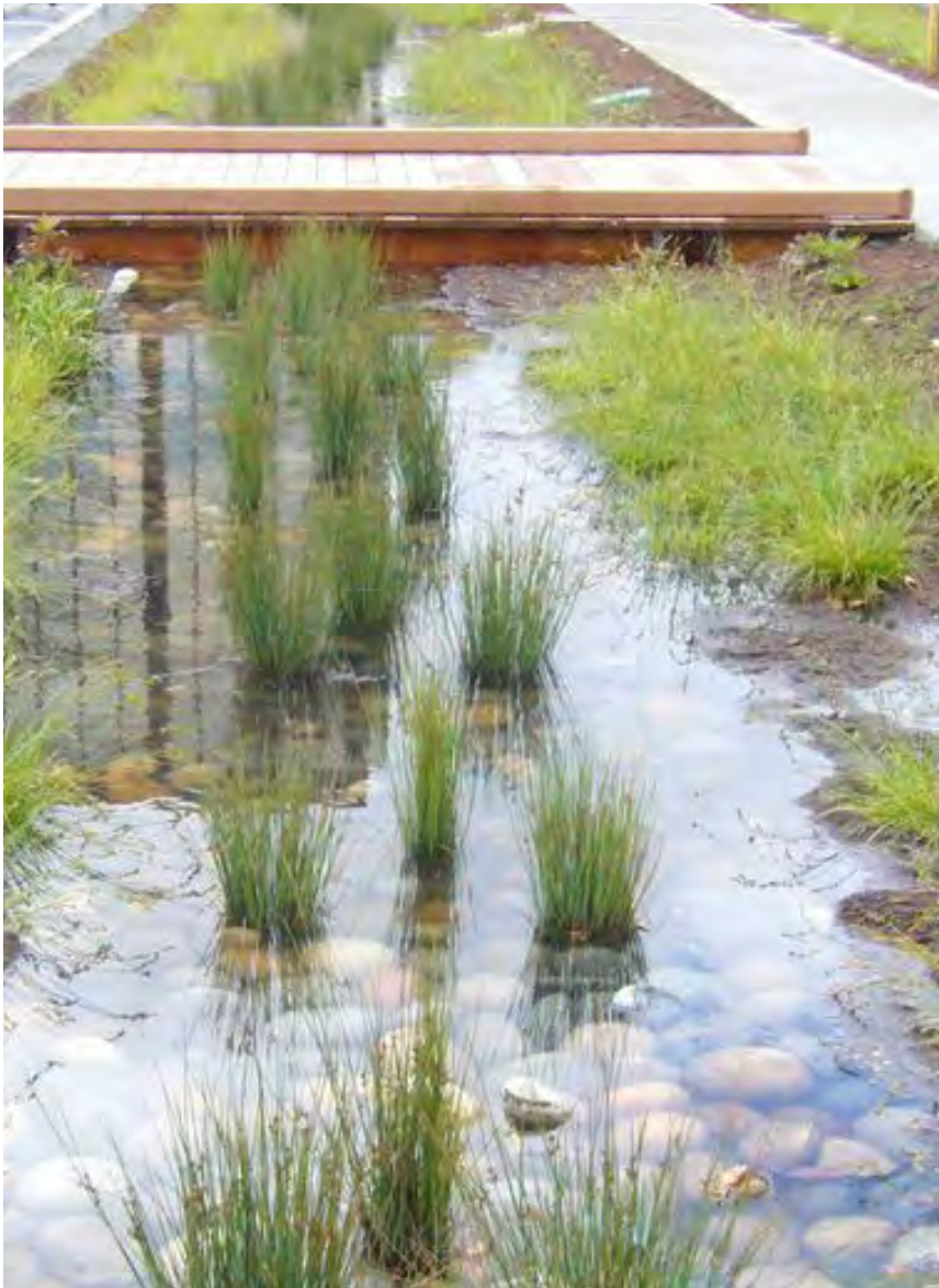
Image de référence de pont traversant une noue
