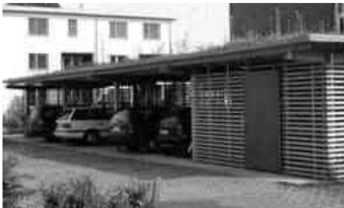
PARKINGS COUVERTS ET SEMI-ENTERRES
