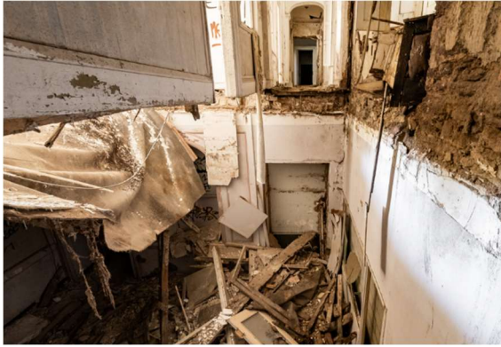
Figure 15 : Partie du couloir du 1er étage du château du XIXe écroulé en 2023
