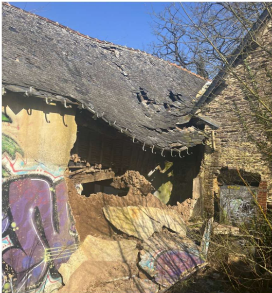
Figure 17 : Bâtiment annexe du XVIIe dont une façade et le plancher intérieur est tombée en 2025.
