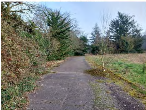
7 : Vue de la voirie existante à l'Est
