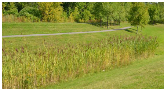
Exemple de bassin d'infiltration
