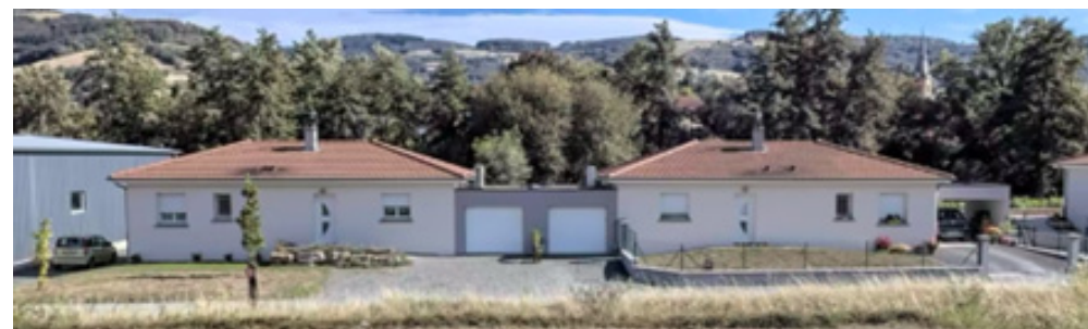
Exemple d'un habitat groupé par les garages sous forme de « plot » SAINT FOY L'ARGENTIERE (69)
