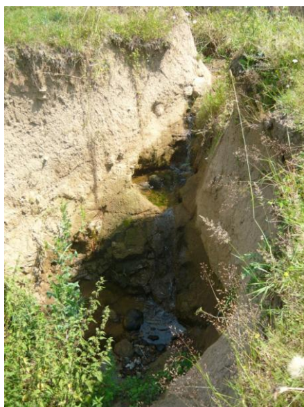
Figure 11 : érosion de berges
