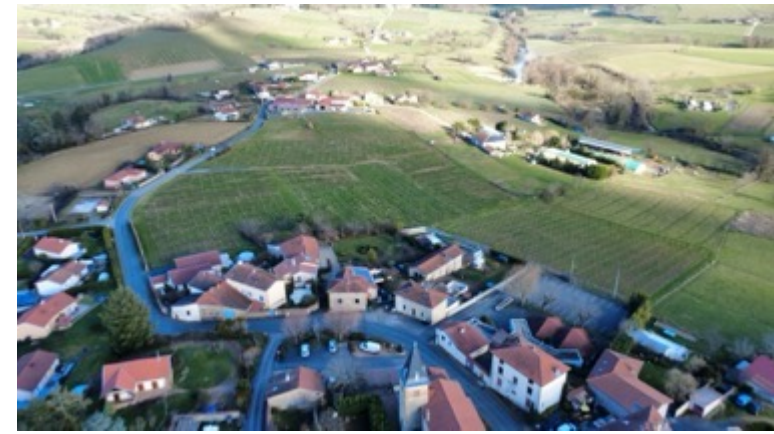
L'unité des volumes et des toitures rouges à pente
