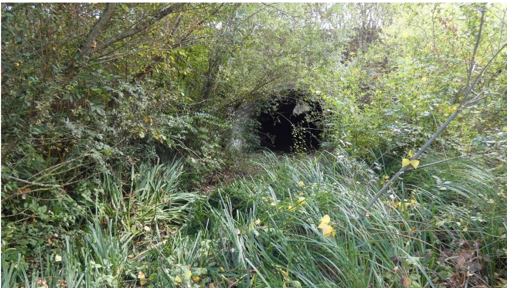
Le passage à faunes sous l'A89 débouchant sur une ripisylve constituant un corridor écologique
