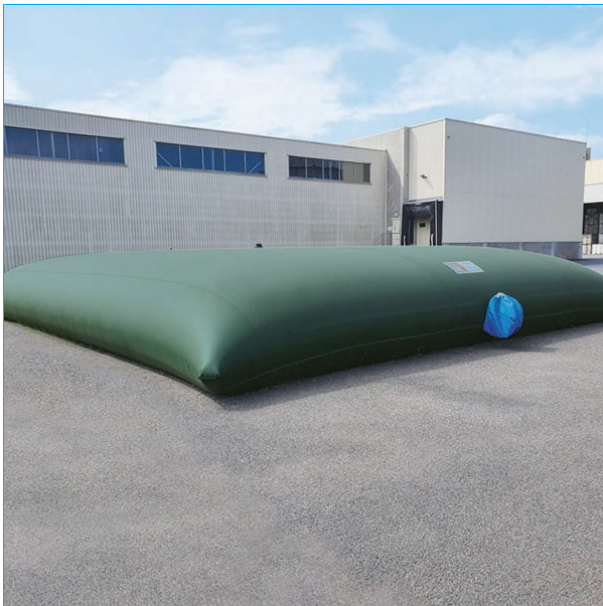
Figure 11 : Illustration réserve incendie en citerne souple - 300 m 3
