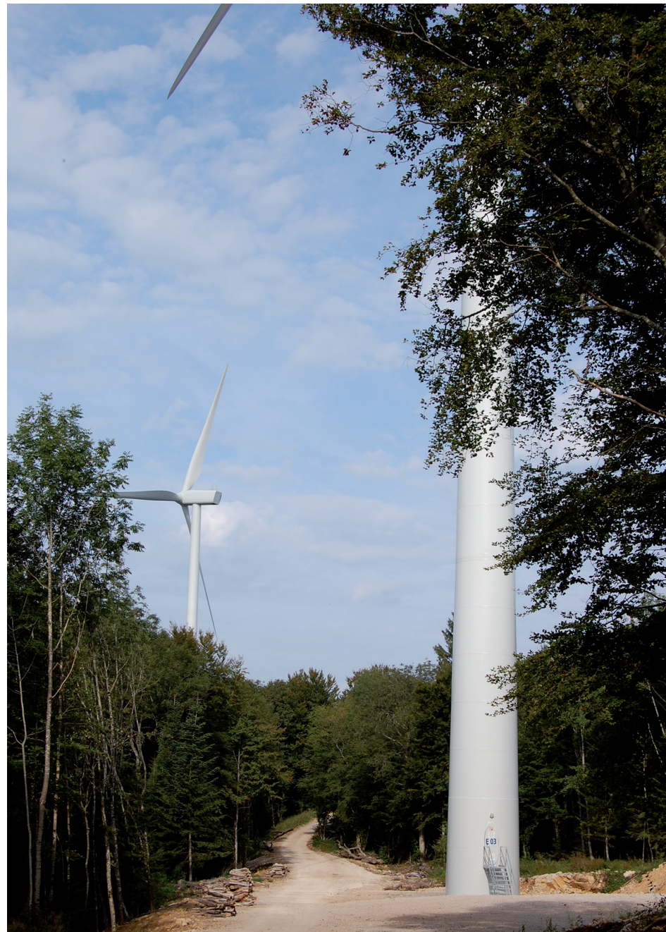
Chemin de desserte des éoliennes sur un parc éolien en forêt - Parc éolien du Lomont
