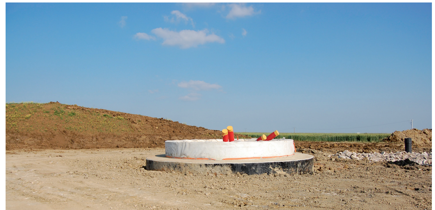
Fondation recouverte de remblais naturels
