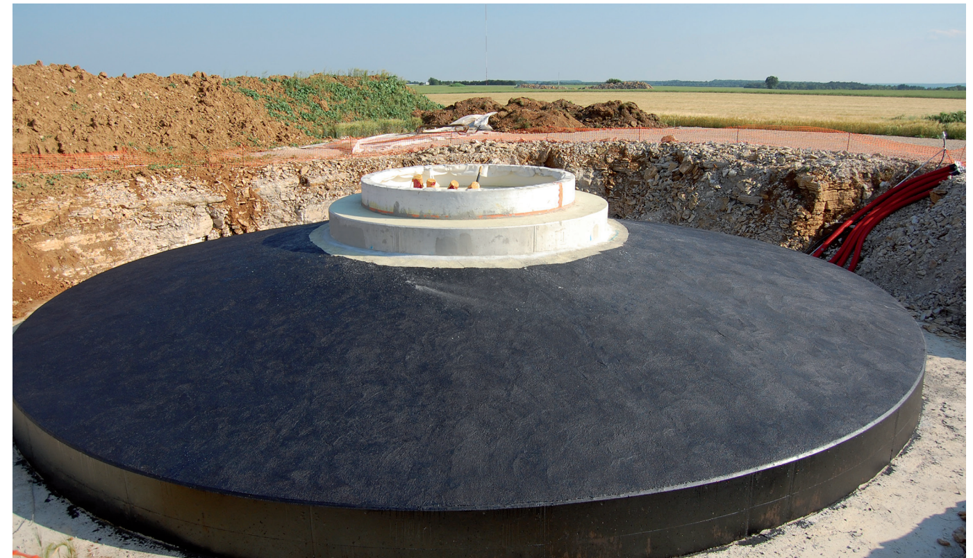
Fondation après coulage du béton
