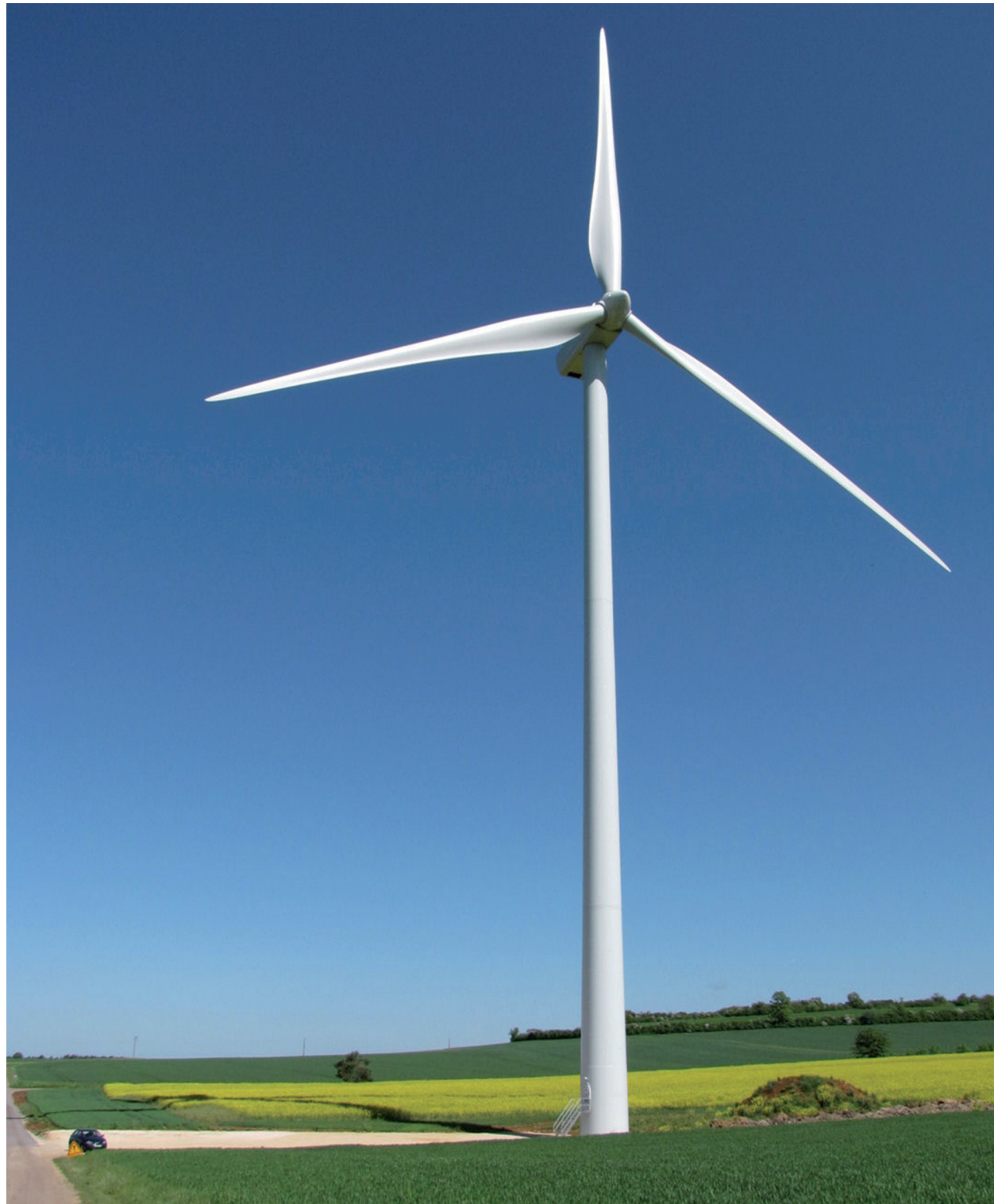
Plateforme de grutage d'une éolienne en culture - parc éolien Saint Seine
