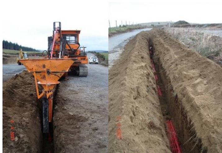
FIGURE 2 : REALISATION DE LA TRANCHEE ET POSE DES CABLES
