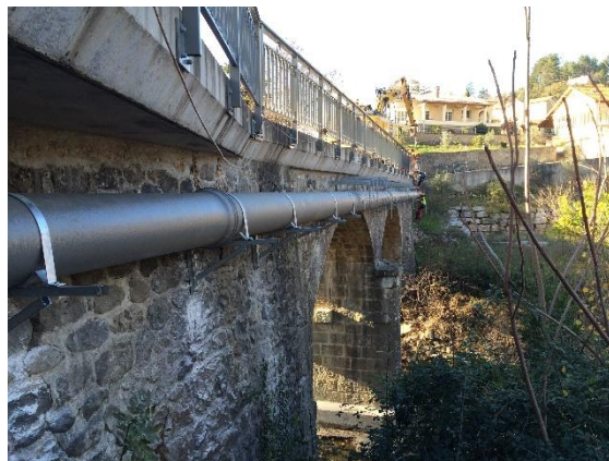
FIGURE 5 : EXEMPLE D'ENCORBELLEMENT (SOURCE : RAMPA-TP.COM)
