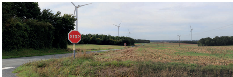
Parc éolien P2 : SASU EOLIENNE COURCOME (EX JUWI SPV7) Source : ARTIFEX
