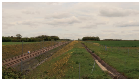
La LGV, fracture au sein du paysage Source : ARTIFEX
