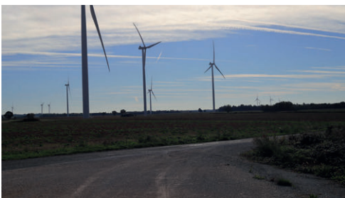
Éoliennes, infrastructure verticale Source : ARTIFEX
