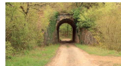
Pont en pierre de l'ancienne voie ferrée
