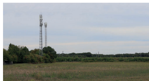
Antennes réseau à proximité de la LGV
