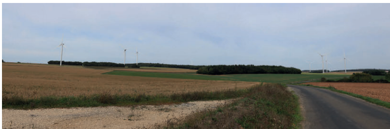
Parc éolien P8 : JALADEAUX SARL Source : ARTIFEX
