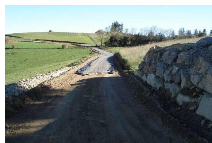
Illustration 21 : Mise en place du gravier
