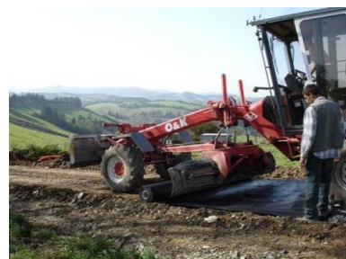
Illustration 20 : Pose du géotextile
