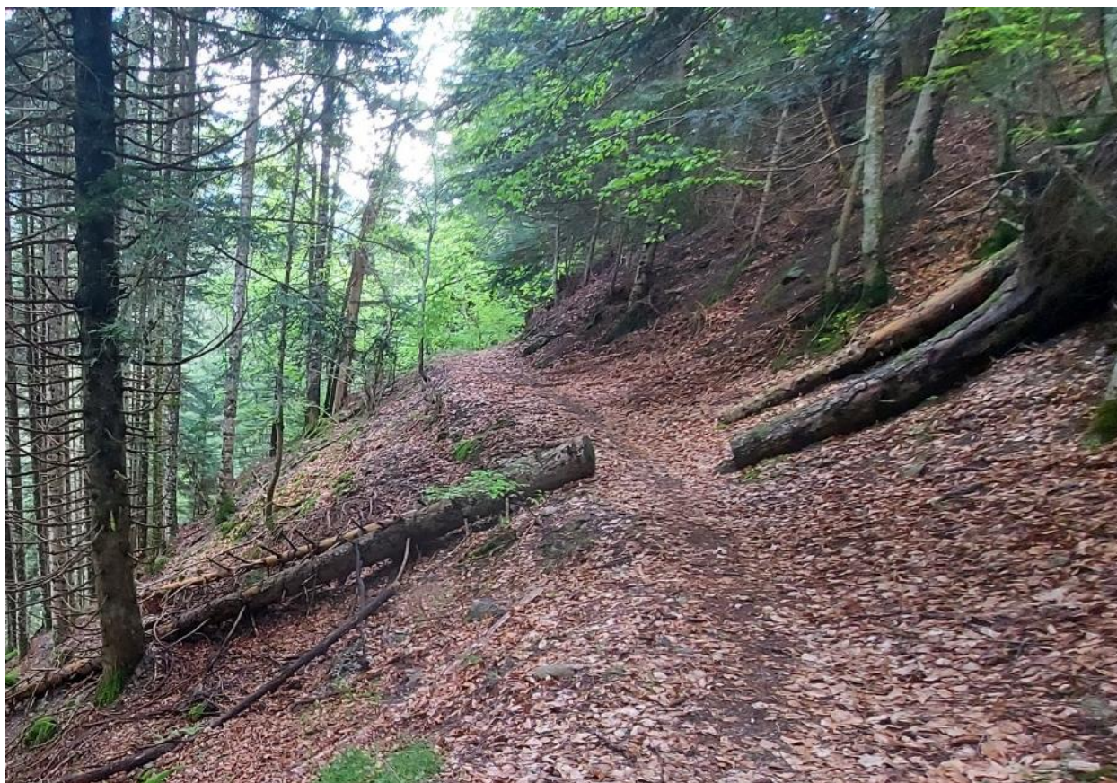
Figure : Vue du chemin forestier qui sera élargi à l'amont dans le cadre du projet. La largeur du chemin actuel varie entre 1 mètre et 2 mètres - Source : KARUM, 2018/2025
