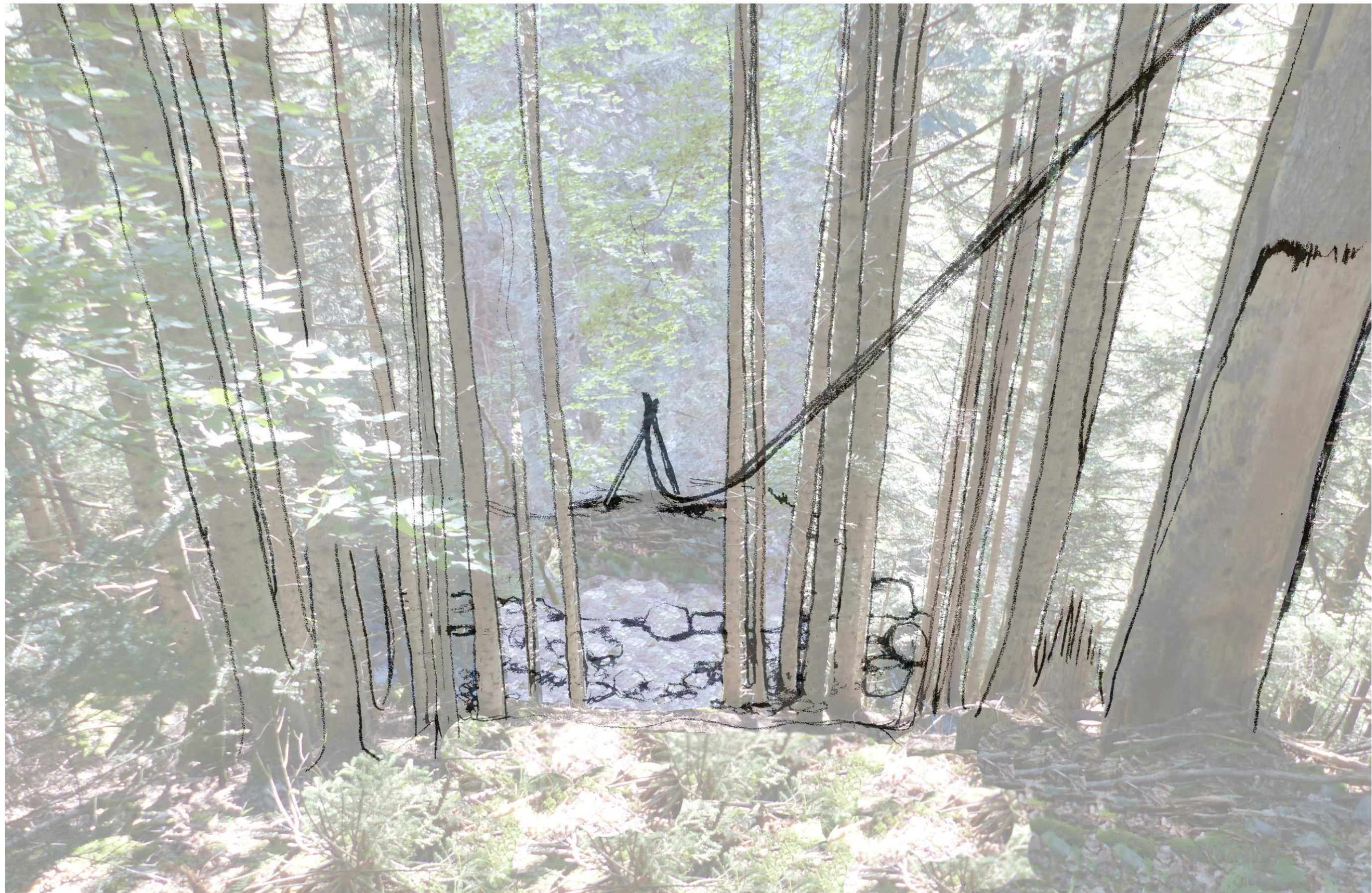
Figure : Simulation paysagère de l'installation du blondin. L'emplacement de fuseau de 2 mètres dans la zone de roulement permettra de réduire l'abattage d'arbres à quelque exemplaire - Source : KARUM, 2023
