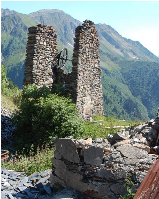
Figure : Ruine des installations de descente des ardoises - Olivier Pasquet 2017
