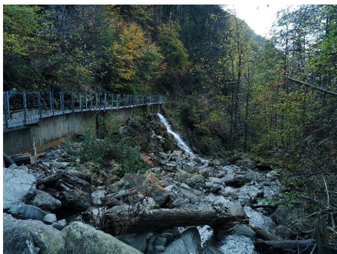
Figure : Prise d'eau existant d'ALTÉO depuis la rive droite du torrent de Bénétant (avant travaux) - KARUM, 28/10/2022
