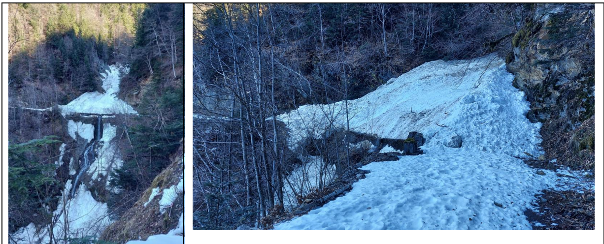
Figure 57. prise d'eau du Grand Nant : illustration de l'accumulation de neige sur la route -'avalanche de février 2026
