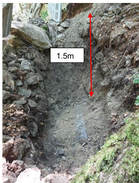
Figure 30. Vue de la fouille à la pelle araignée
