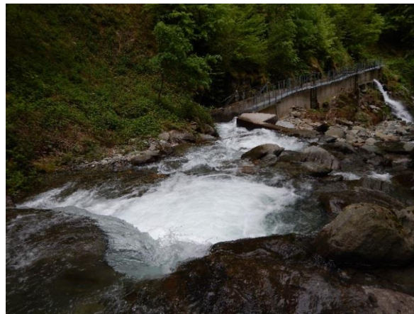
Photo 17: Vues de la prise d'eau Altéo existante (côte 841 m NGF) et de l'exutoire assurant le débit réservé (ouvrage infranchissable à la montaison et à la dévalaison)
