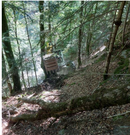
Figure 29. Réalisation du sondage à la pelle araignée
