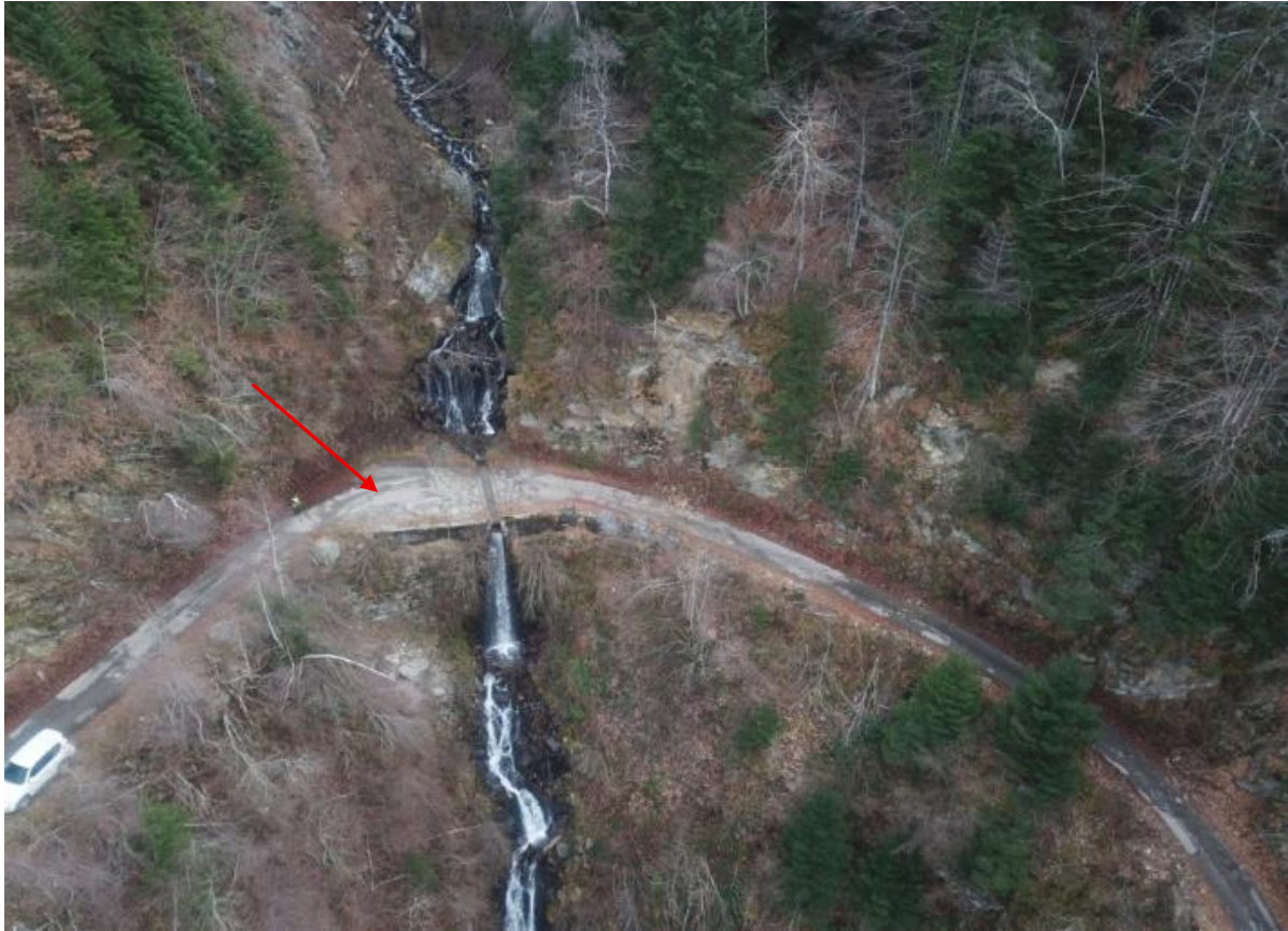
Figure 55. prise d'eau du Grand Nant : vue aérienne par drone(photo B Pilot)
