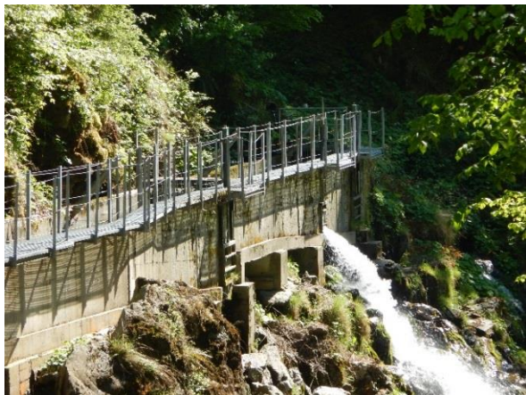
Photo 17: Vues de la prise d'eau Altéo existante (côte 841 m NGF) et de l'exutoire assurant le débit réservé (ouvrage infranchissable à la montaison et à la dévalaison)
