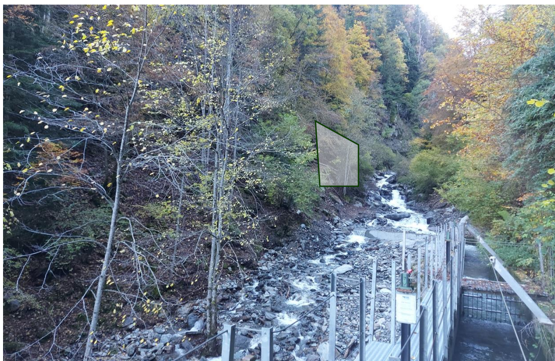
Figure : Vue du site de la future centrale de Bénétant depuis la prise d'eau existante d'ALTÉO avant travaux de 2023 - Source : B.PILOT, août 2018
