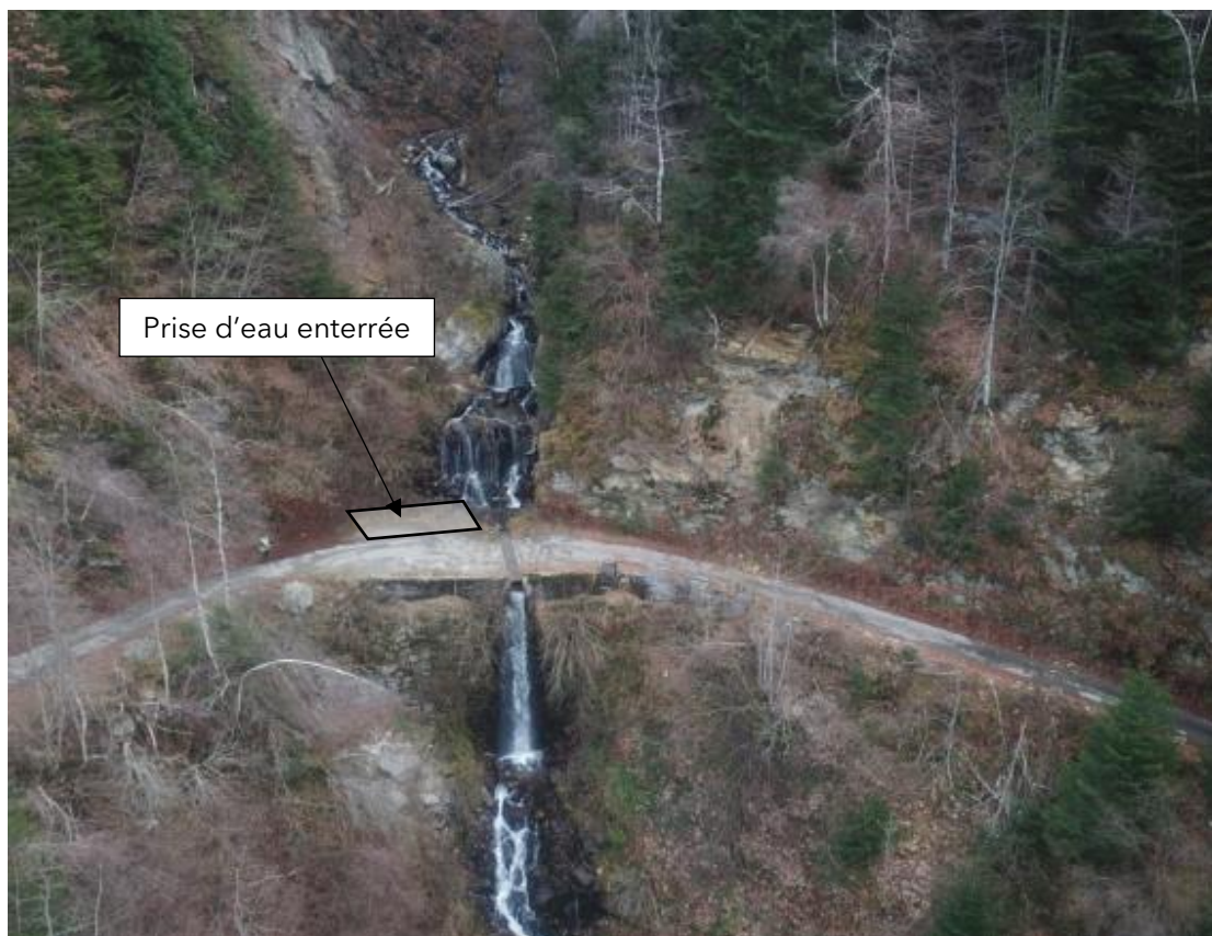
Figure : Vue par drone de l'implantation de la prise d'eau du Grand Nant – Source : B.PILOT
