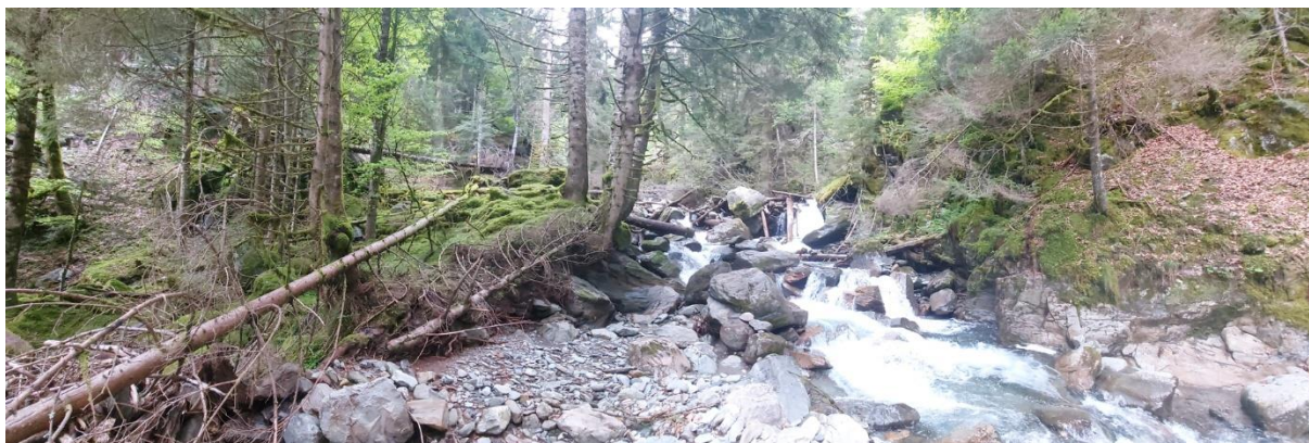
Figure : Vue de l'implantation de la future prise d'eau de Bénétant prise depuis l'aval - Source : B.PILOT
