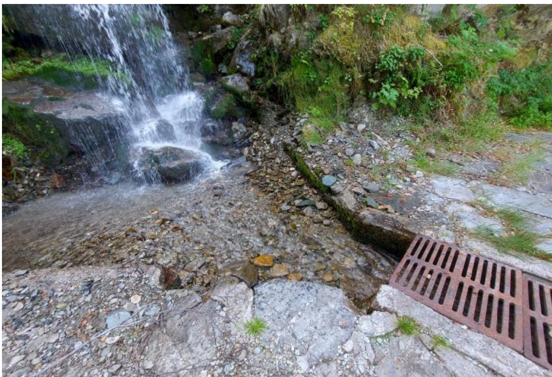
Figure : Vue de l'entonnoir existant et de l'évacuation des eaux en traversée de chaussée par le caniveau - Source : B.PILOT
