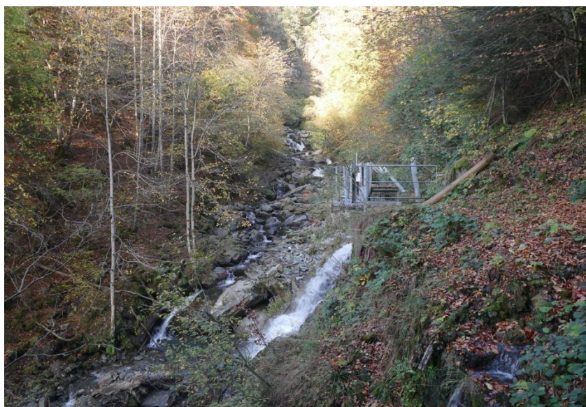
Figure : Vue de la prise d'eau d'ALTÉO, photo prise de l'aval vers l'amont - Source : B.PILOT, 2018
