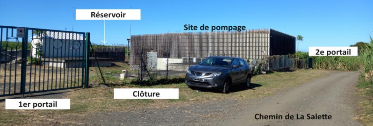
Figure 12 : Site accueillant le forage, le réservoir et la station de pompage de la Ligne Paradis
