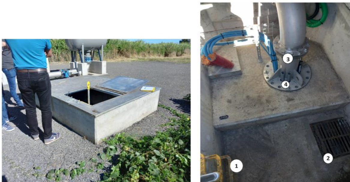
Figure 10 : regard semi enterré contenant la tête de l'ouvrage
