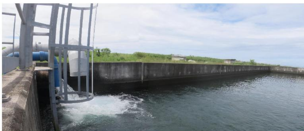
Figure 7 : Refoulement des eaux du forage vers le réservoir Ligne paradis (source Mascareigne Géologie, 2024)
